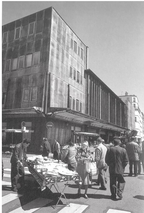
III. 6. Vista geral, lado dos escritórios, antes do restauro. Foto de 1990.
