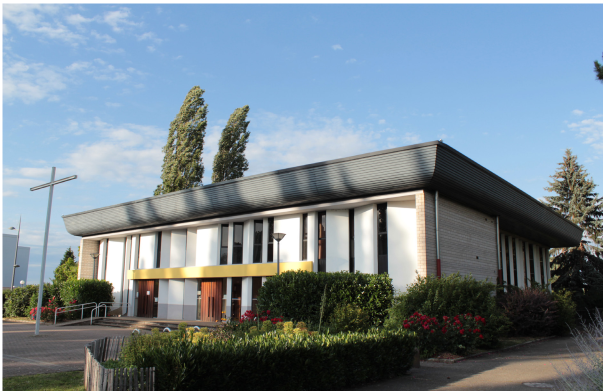
Ill. 1 Vue des façades ouest et sud de l'église du Christ-Roi à Bischheim (cliché Cécile Rivière, 2020)
