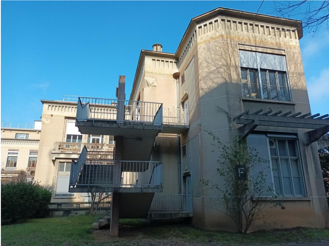
Fig. 15 – Vue du pavillon F (les escaliers ont été ajoutés dans les années 1980) – Photo © Philippe Dufieux, février 2025.
