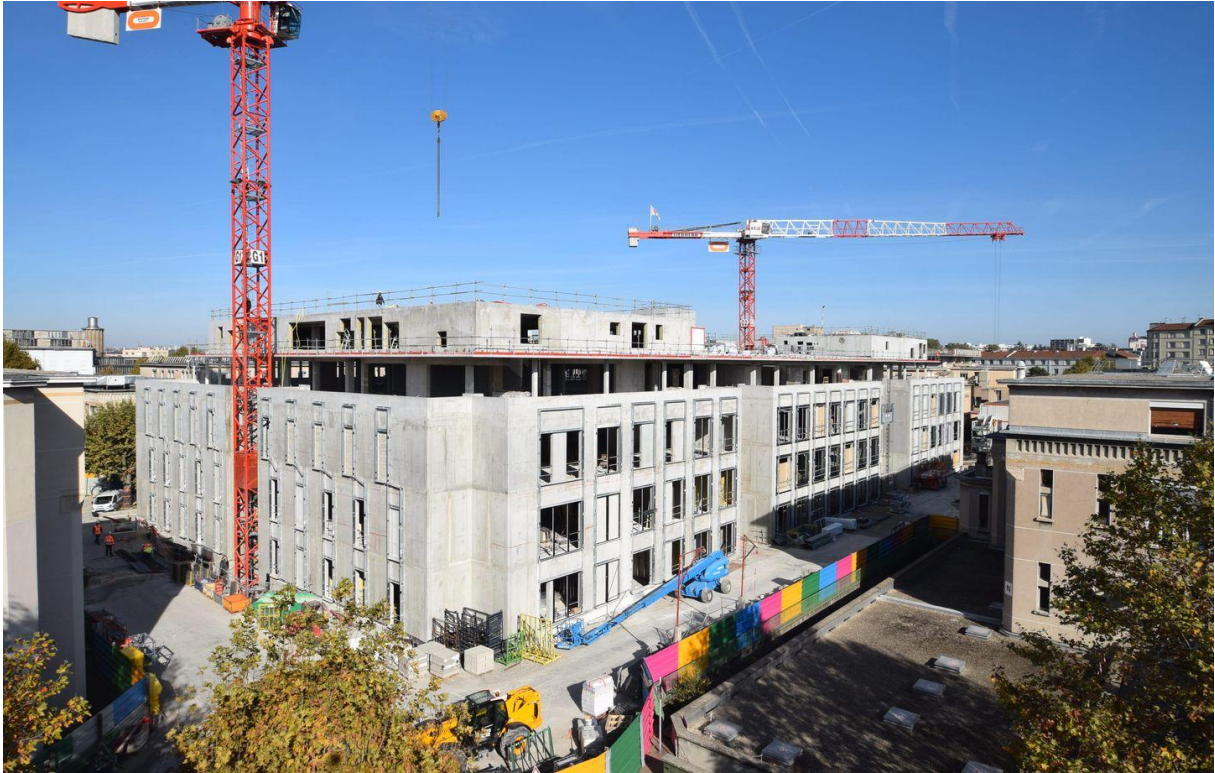
Fig. 7 – Le nouveau pavillon H en construction. Source : 20 minutes , 10 novembre 2016.
