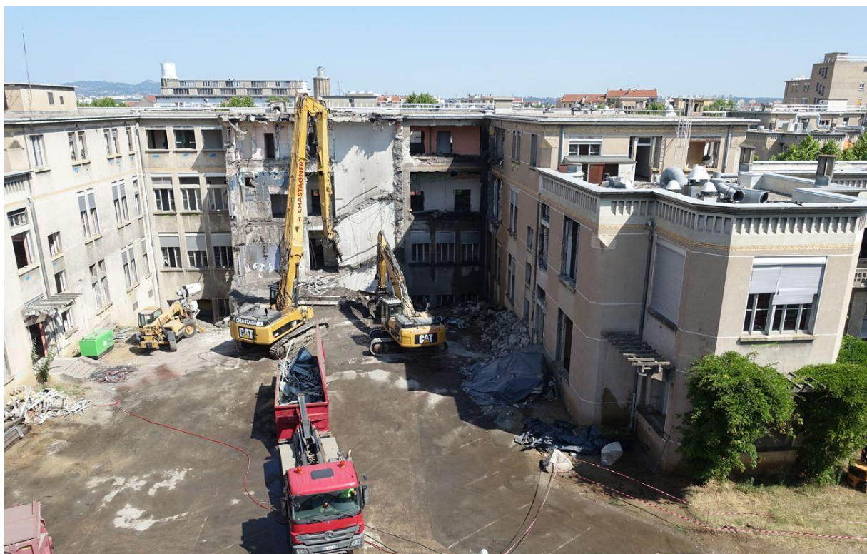
Fig. 6 – La démolition du pavillon H (juillet-novembre 2015). Source : 20 minutes, 15 juillet 2015.
